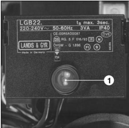
El cajetín de control y seguridad LGB 22 se utiliza para garantizar el control y la vigilancia de quemadores de gas con una y dos etapas.
