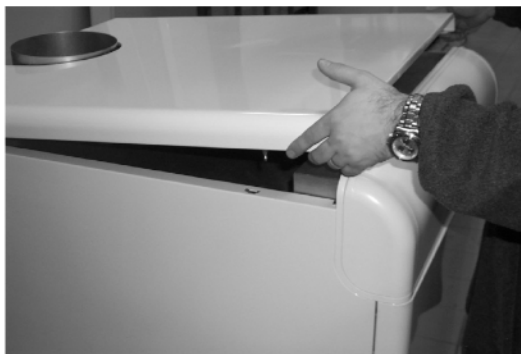
Fig. 4 - Levantar, con una presión de abajo hacia arriba, y quitar la tapa que esta sujeta a los Laterales de la caldera mediante pivotes y muelles.
